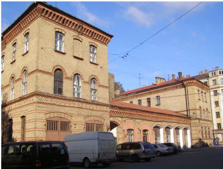
63.attēls Ugunsdzēsēju depo Akmeņu ielā 17, 2007.gads. Foto M.Kalvāne
