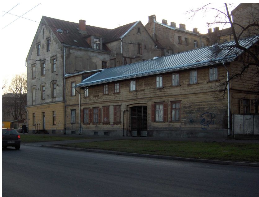
54.attēls Akmeņu iela 13, Valguma ielas fasāde, 2007.gads. Foto M.Kalvāne
