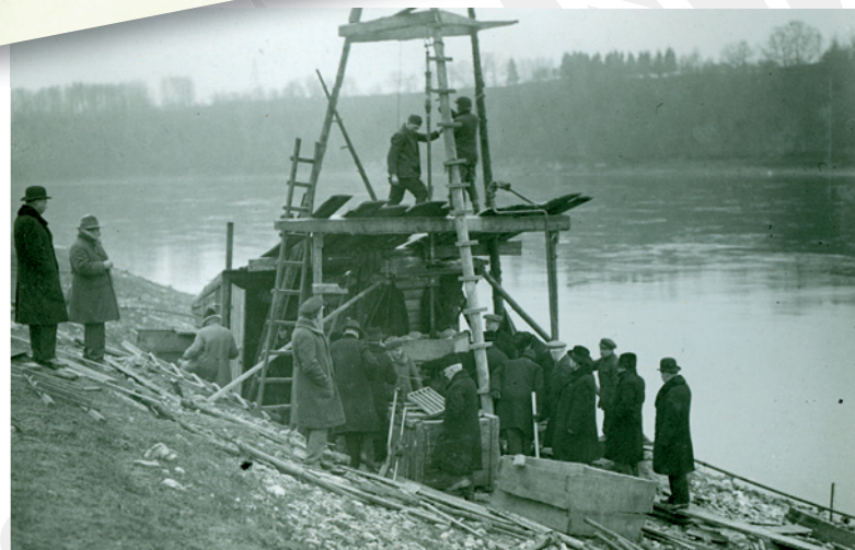
«The Foundation Company» veiktie urbumi iespējamajās Ķeguma spēkstacijas vietās. 1933. gads Boreholes in the possible construction sites of the Ķegums HPP drilled by The Foundation Company, 1933
