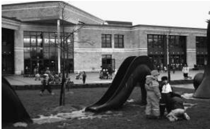
Bâtiment Ecole Maternelle; Foto: Jarmo RAUTIO
