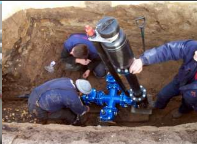
Ūdenssaimniecības rekonstrukcija Pāvilostā
