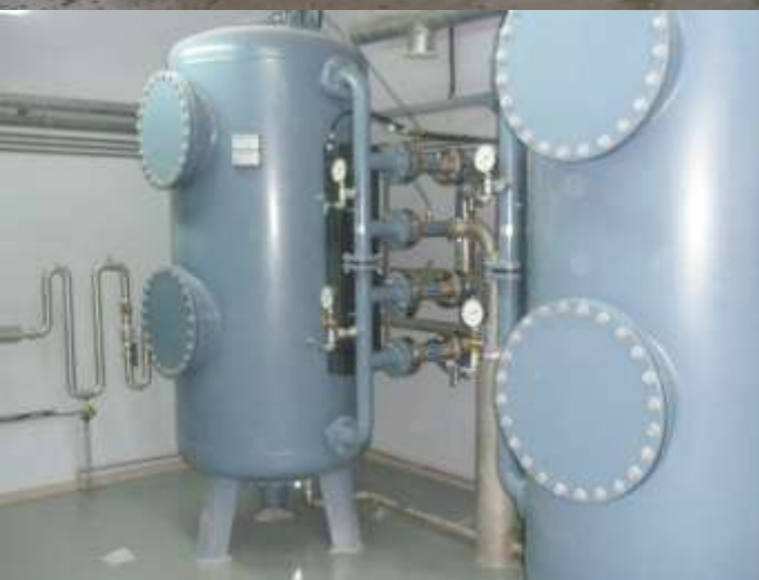
Jaunā ūdens atdzelžošanas stacija un iekārtas Kārsavā
