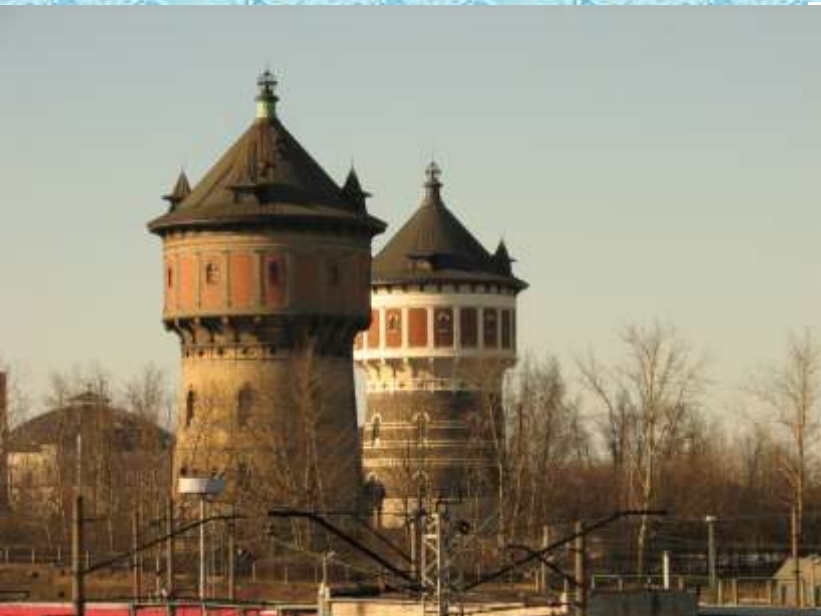
Ūdenstorni Mazajā Matīsa ielā
