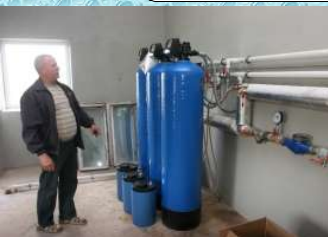
Jauna dzeramā ūdens atdzelžošanas iekārta Jaunalūksnes pagastā
