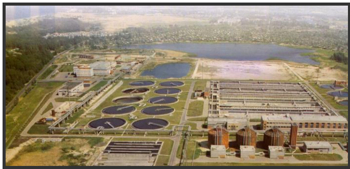
6.6. attēls. Rīgas notekūdeņu attīrīšanas komplekss Daugavgrīvas salā. Foto – p/u "Rīgas ūdens".
