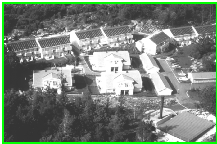
6.3. attēls. Saules enerģijas kolektori ir īpaši piemēroti, lai nodrošinātu centralizētu siltumapgādi. Saro, netālu no Gēteborgas, Zviedrijā ir izveidota sistēma, kas nodrošina nelielu dzīvojamo teritoriju ar 48 dzīvokļiem, izmantojot 740 m 2 jumta laukumu, kur ir izvietoti kolektori kombinācijā ar 640 m 3 ūdens cisternu, kas atrodas klints šahtā. Sistēma darbojas kopš 1989. gada un nodrošina 35 % no vajadzībām, saražojot gada laikā 400 MWh. Palielinot sistēmu, varētu panākt 65 % enerģijas nodrošinājumu.
