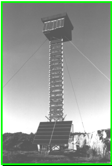
6.5. attēls. Gaismas konversijas iekārta Stokholmas arhipelāga Bulero salā pilnībā nodrošina vienas ģimenes vajadzības - apgaismojumu, kā arī ledusskapja, radio, TV un citu vienkāršu mājsaimniecības ierīču darbību. Masta augšējā daļā ir izvietoti 33 vatu bloki (1980. gada modelis), bet apakšējā daļā - 55 vatu bloki (1996. gada modelis). Sistēmā izmanto 48 voltu spriegumu, un tai ir pievienots 750 amperstundu akumulatoru bloks. Maksimāli pieļaujamā slodze ir 1,45 kW. Tiek nodrošināta strāvas pārveide uz 220 V maiņstrāvu. Sistēma kopumā izmaksāja apmēram 20 000 ASV dolāru. Neliels vēja ģenerators ziemā papildina sistēmas jaudu, bet kā rezerves avots ir izmantojams dīzeļdzinējs. Foto - M. Andersson, kas pats arī montēja šo sistēmu.
