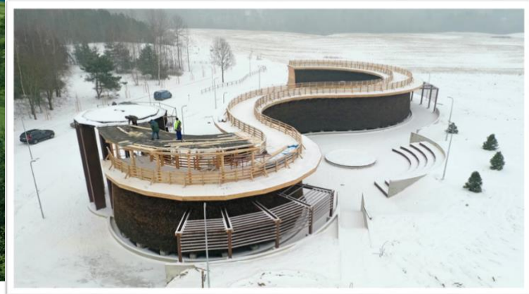
Saīlsūdens tornis Miłomłyn (tiek būvēts)
