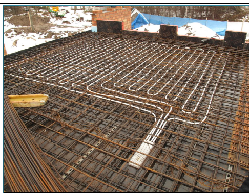
att. 2 Caurulvadi betona pārseguma nesošajā karkasā un veidņu izvadkārbā
