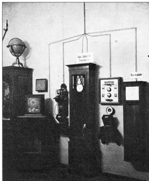
Attēls. “Rīgas Politehnikas laika dienesta ierīce” (L. Slaucītājs). Plāksnītē uz lielākā pulksteņa rakstīts: Peterburger Zeit (Pēterburgas laiks). Denckera pulkstenis atrodas pa labi
