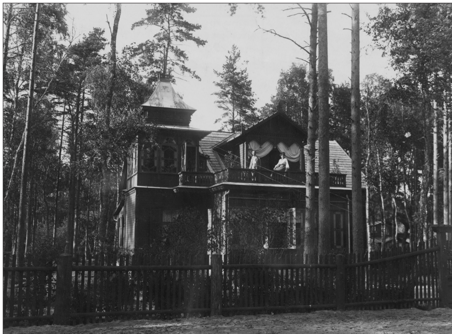
Attēls. Rainis un Aspazija uz Jaundubultu vasarnīcas balkona 1905. gadā.
