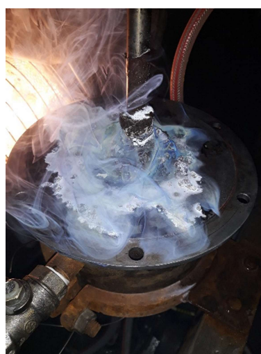
Fig. 2.17. Apakšējais reaktora vāks pēc demontāžas (redzami dūmi)
