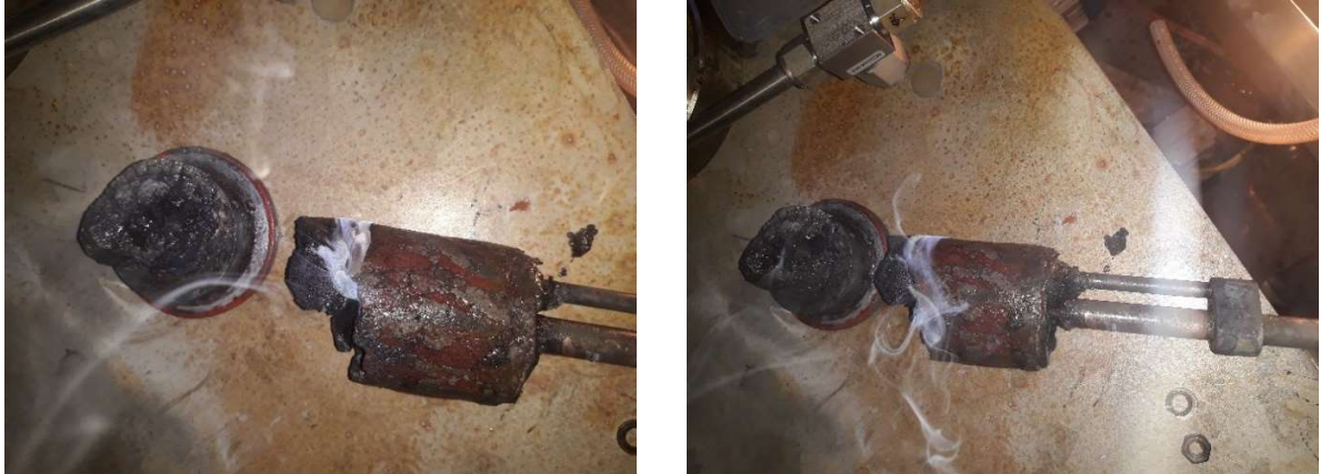
Fig. 2.3. Nerūsējošā tērauda aizmetnis pa kreisi un demontēta sārņu vanna kopā ar elektrodiem.
