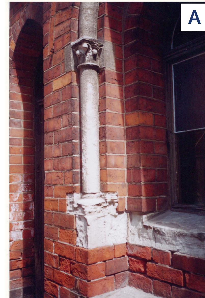
Pilsētvidē dēdējuša gaiši pelēcīgā dolomīta detaļas Doma baznīcas sienā 2003.gadā (A) un paraugs analogs (B) iespējamai aizvietošanai no devona perioda dolomītu slāņkopas. LU Muzeja krājums
