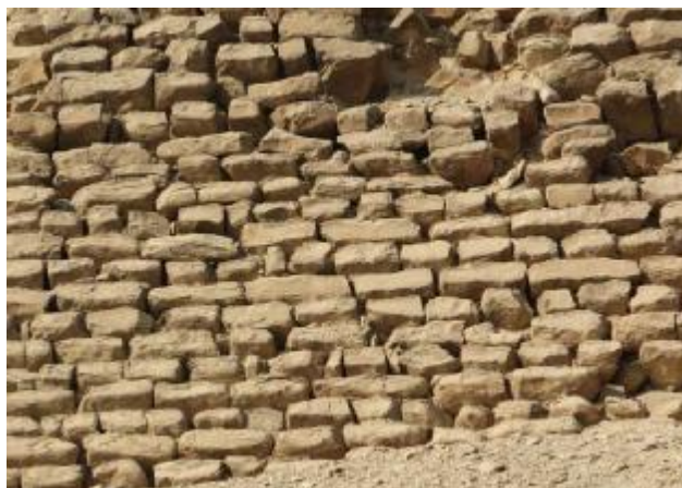
5.10. attēls. Valdnieka Džosera piramīdas augšējās daļas būvbloku kvalitāte (ceturtā pakāpiena fragments, dienvidu fasāde).
