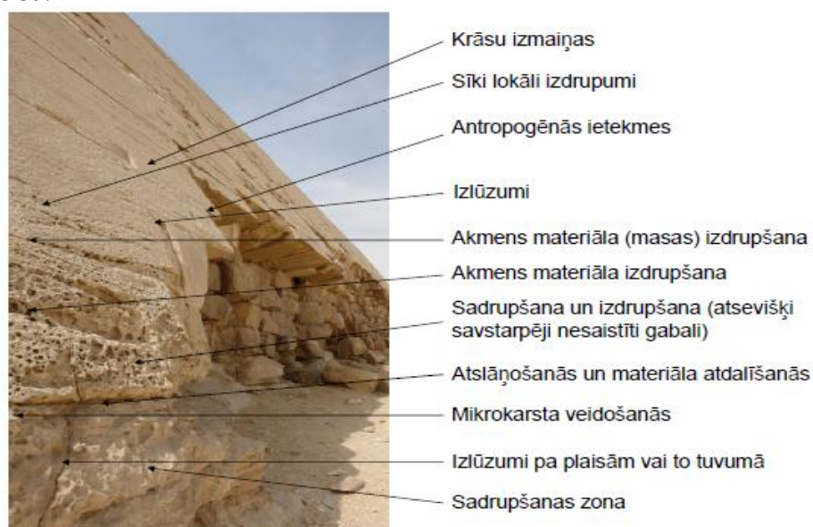
4.9. attēls. Dēdēšanas paveidu diagnostika Rombveida piramīdas (Dašūra) ziemeļu fasādes parauglaukumā.
