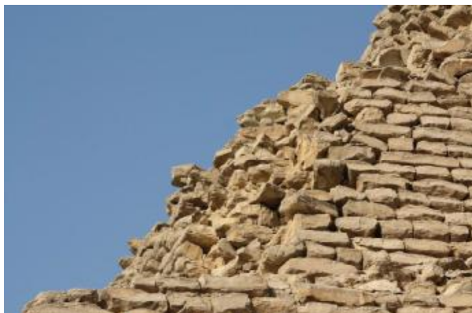
5.8. attēls. Raksturīga būvbloku kvalitāte piramīdas apakšējā daļā. Pakāpju piramīdas dienvidu fasādes otrā pakāpiena fragments.
