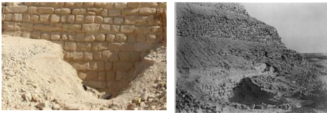
5.9. attēls. Piramīdas pamatnē jeb „0” pakāpienā izmantotie būvbloki (rietumu fasāde); pa kreisi – 2010.gada fotouzņēmums; pa labi – 1930-to gadu fotouzņēmums (Firth, Quibell, 1935, 9. att.).
