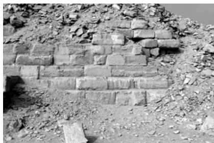
1.attēls. Raksturīgi Unis piramīdas ārējās apdares akmens bloku dēdēšanas piemēri.
