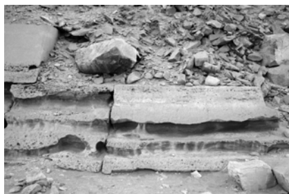
1.attēls. Raksturīgi Unis piramīdas ārējās apdares akmens bloku dēdēšanas piemēri.
